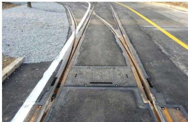
<그림 84> 매립형분기기의 설치
