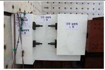
<Static Actuator 설치, 인장실험 전경>
