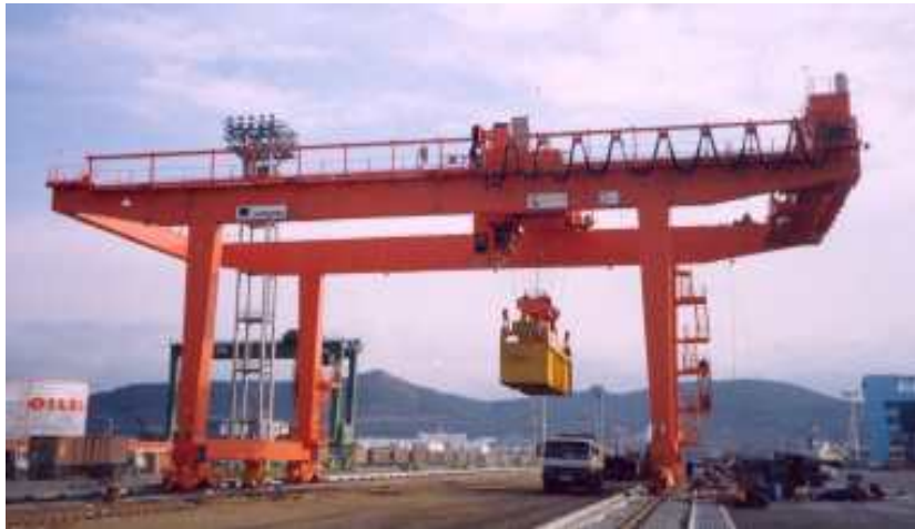
<그림 2-32> RMGC(Rail-Mounted Gantry Crane)
