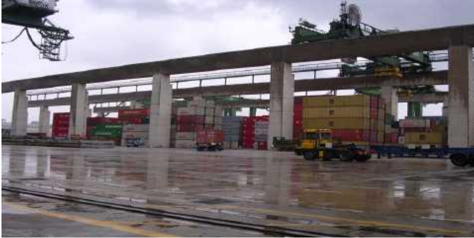
<그림 2-39> OHBC(Over Head Bridge Crane)
