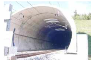
그림 2.3.31 프랑스 Tartaignille 터널, Roque-Rousse 터널 등의 터널입구 후드
