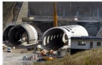
그림 2.3.30 프랑스 미기압과 저감후드: 시계 방향으로 후드전면 경사각 모습, 후드 내부에서의 창문 모습, 후드 시공모습
