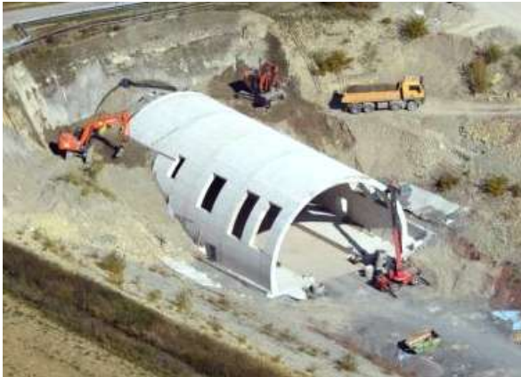
그림 2.3.27 독일 Bleßberg Tunnel(연장 8.314 km, 외부연결 사갱 8개소)에 설치된 슬롯형 터널 미기압과 저감 후드(터널 내공단면적 92m 2 , 2017년 개통예정)
