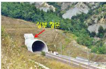
그림 2.3.31 프랑스 Tartaignille 터널, Roque-Rousse 터널 등의 터널입구 후드
