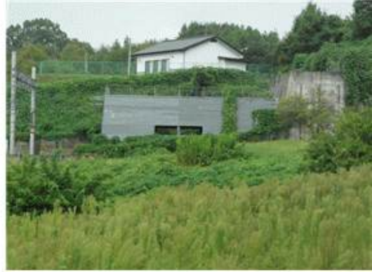
그림 2.3.37 일본 동북 신칸센의 미기압과 저감용 터널입구 “창문형 후드”의 상세사진(1998년형으로 추정됨)
