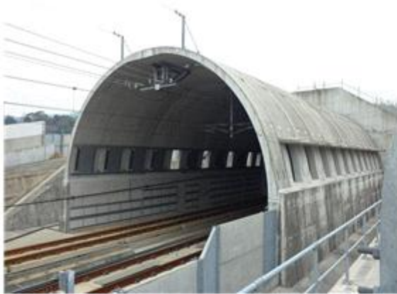
그림 2.3.32 일본 산양 신칸센의 강제구조(데크 플레이트)의 터널입구 후드
