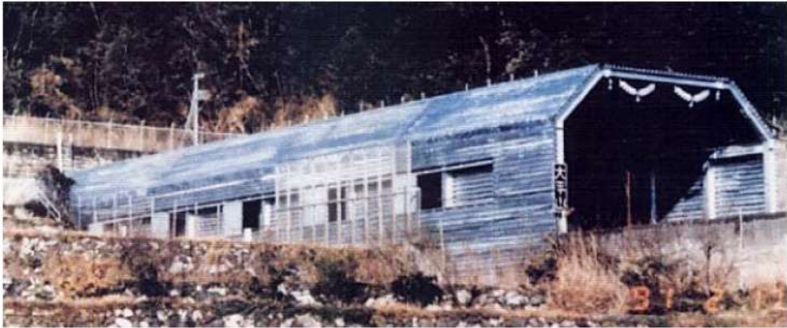
그림 2.3.42 일본 산양 신칸센 오히라야마 터널(연장 6.64 km, 콘크리트 궤도)에 설치된 장대터널용 터널입구 후드(후드길이 49m)
