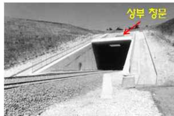
그림 2.3.31 프랑스 Tartaignille 터널, Roque-Rousse 터널 등의 터널입구 후드
