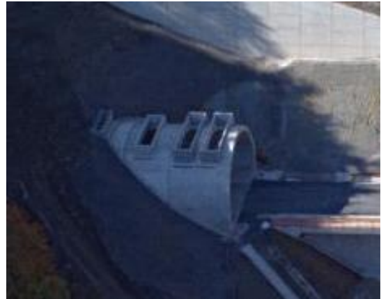
그림 2.3.27 독일 Bleßberg Tunnel(연장 8.314 km, 외부연결 사갱 8개소)에 설치된 슬롯형 터널 미기압과 저감 후드(터널 내공단면적 92m 2 , 2017년 개통예정)
