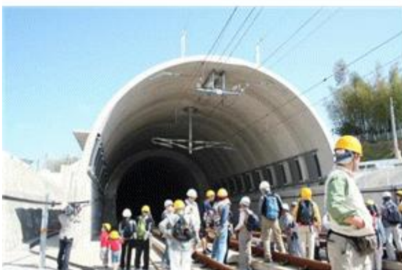
그림 2.3.33 일본 큐슈 신칸센 터널입구 후드(2011년): 콘크리트로 시공한 후드
