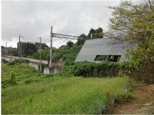
그림 2.3.37 일본 동북 신칸센의 미기압과 저감용 터널입구 “창문형 후드”의 상세사진(1998년형으로 추정됨)
