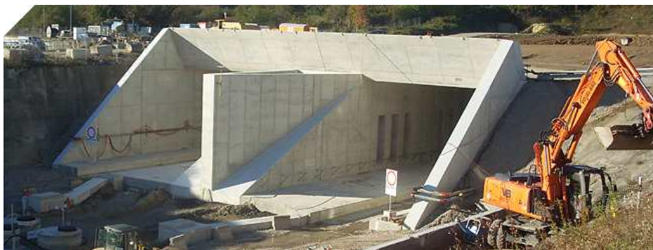
그림 2.3.19 독일 Katzenberg Tunnel(연장 9.385 km)의 북쪽 갱구에 설치된 슬롯형 터널 미기압과 저감 후드(후드길이 50m)
