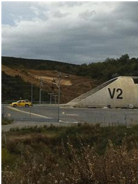
그림 2.3.30 프랑스 미기압과 저감후드: 시계 방향으로 후드전면 경사각 모습, 후드 내부에서의 창문 모습, 후드 시공모습
