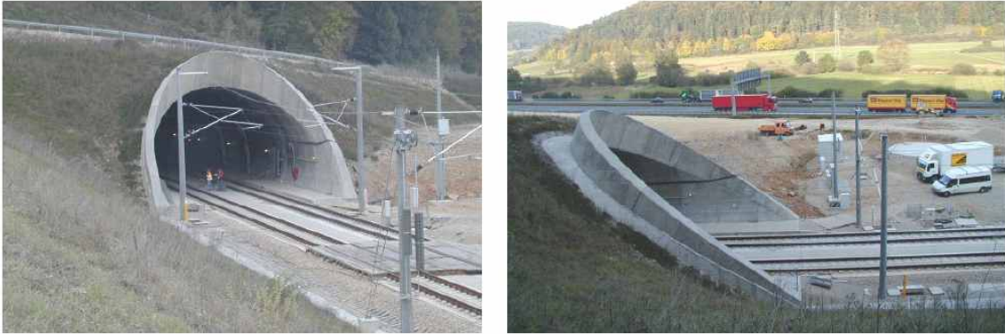
그림 2.3.15 독일 신선의 Euerwang 터널의 벨 마우스 갭문(남쪽 갭구)과 터널 갭구 부근의 A9 도로(갭문으로부터 50m 거리임)
