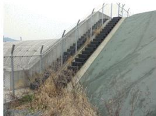
그림 2.3.33 일본 큐슈 신칸센 터널입구 후드(2011년): 콘크리트로 시공한 후드
