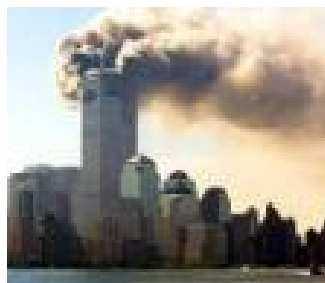
(b) WTC 항공기 충돌 후 화재로 인한 빌딩 붕괴
