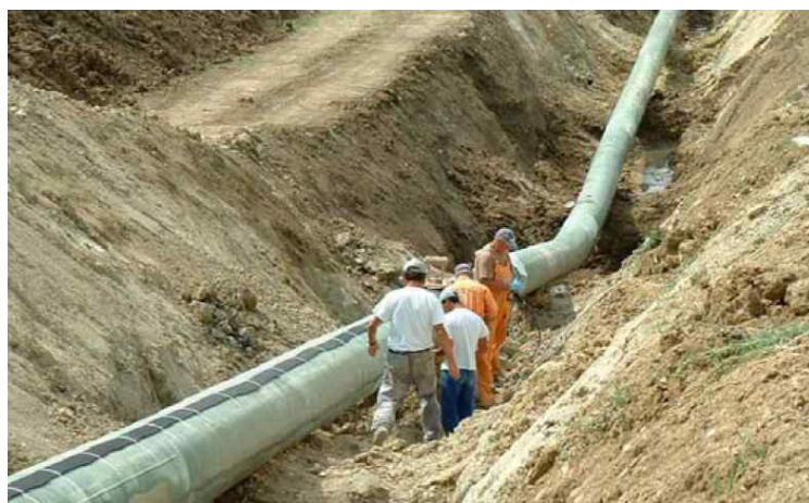
■ 그림 2.4.22 Smartec의 가스배관 SMARTTape 설치 전경 ■
