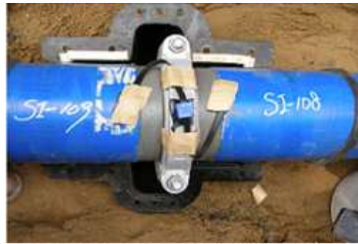
■ 그림 2.3.5 신규 매설관에 적용된 누수감지 기술 ■
