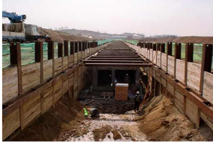
<그림 1.10> 개착공사로 인한 부지점유
