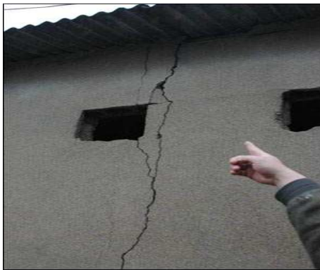
<그림 2.13> 터널 발파진동으로 인한 피해(좌측) 및 집단민원 사례(우측)
