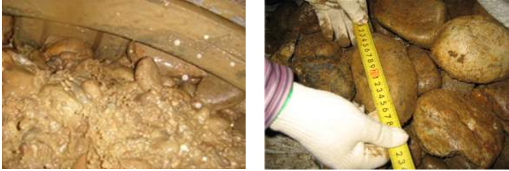
<그림 2.12> 커터헤드 내로 유입된 호박돌로 인한 굴진불능 사례
