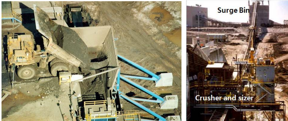
[그림 2.27] Ore Preparation Plant (OPP)
