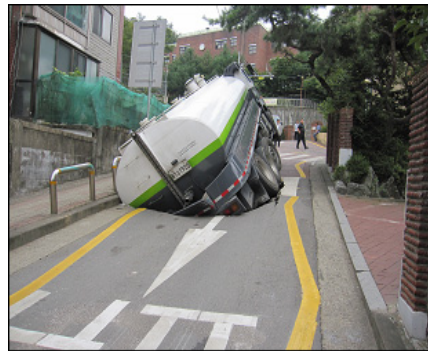
〈그림 2-17〉 기존 GPR탐사 방법과 하수관 노후화로 인한 붕괴사고
