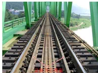
(b) 교량의 안전시설
