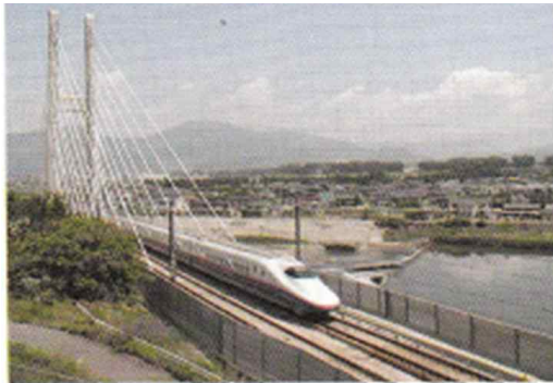
그림 2.25 The 2nd Chikuma River Bridge-사장교(Japan)
