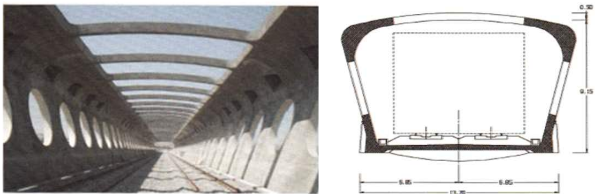
그림 2.43 Ebro River Bridge-하로 PSC 박스형 거더교(Spain)
