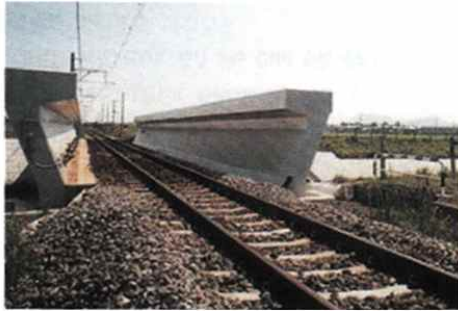
그림 2.28 Nishi-Gojodori Kado, Tantogawa, Otsugawa, Kita-Mikawa Bridge-하로 U형 거더교(Japan)
