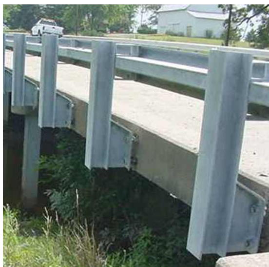
그림 3.33 Hollow Box 구조를 이용한 충격 흡수 가드레일(미국)
