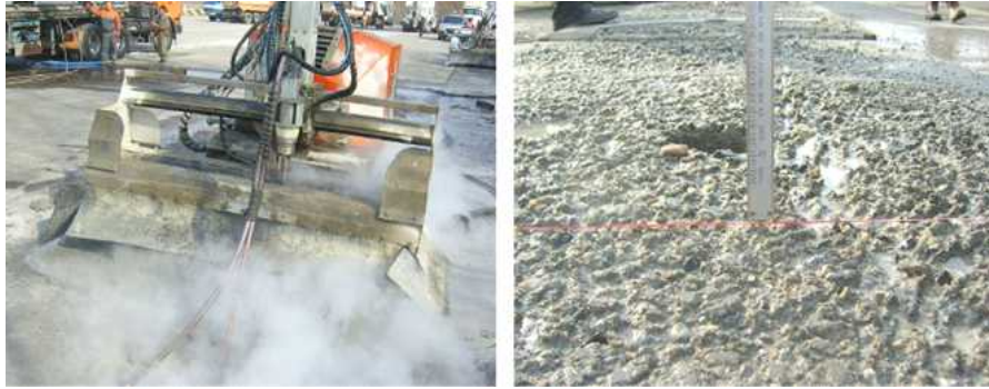
그림 3.32 Water Jet를 이용한 콘크리트 파쇄
