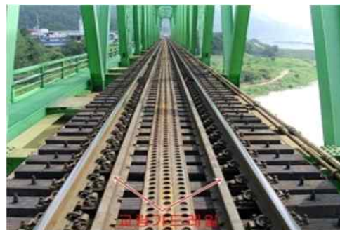
(b) 교량의 안전시설
