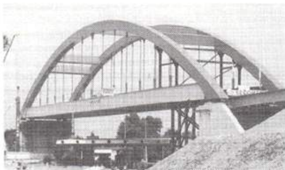
그림 2.31 Peage A7 Bridge-하로 강아치교(France)
