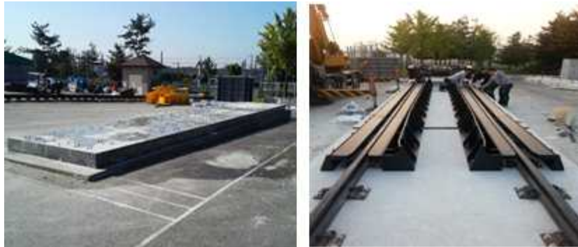
<프리캐스트 슬래브 궤도(PSTS) 및 레일 설치 (15m)>
