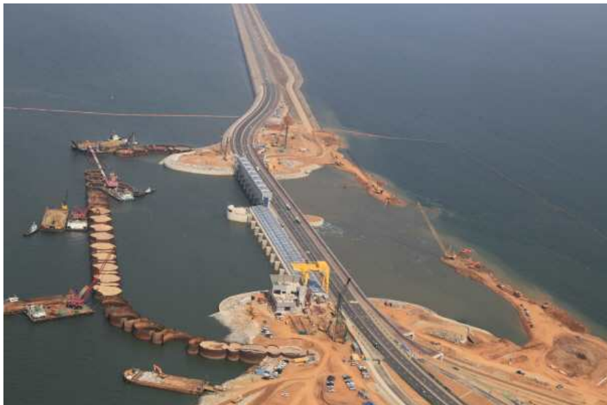
[그림 2.8] 원형 및 아크형 셀식 가물막이
