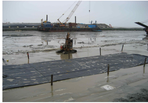
(b) Post Pile 설치 및 지오투브 포설
