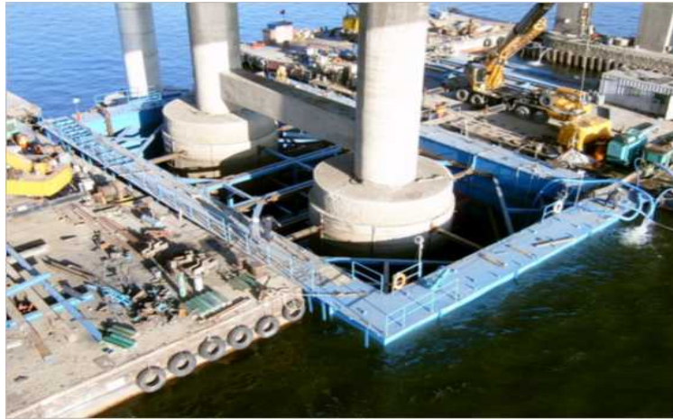
[그림 2.11] 케이슨 튜브 가물막이 공법의 케이슨 설치
