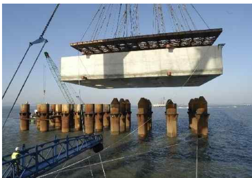
(g) PC House 설치
