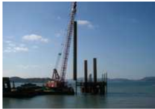
(d) 영구케이싱(희생강관) 설치
