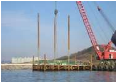
(c) Jig Jacket 설치
