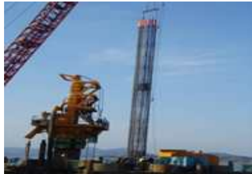
(f) 철근망 설치
