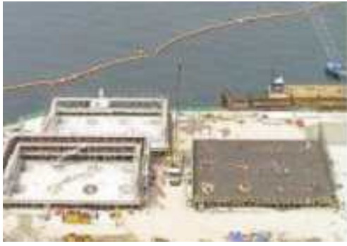
(a) Jig Jacket 및 PC 하우스 육상 제작
