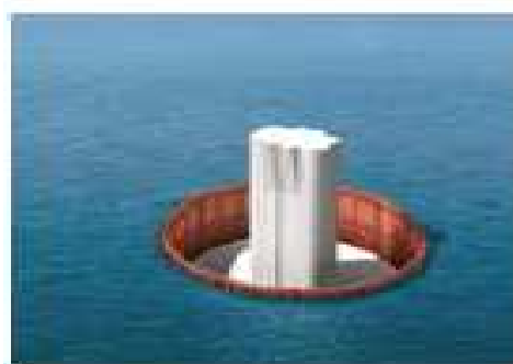
(d) 구조물 시공
