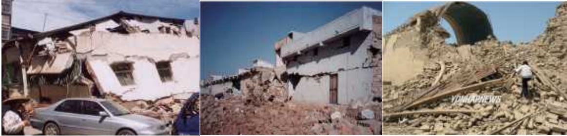
[그림 8-15] 조적조 저층 건축물의 지진피해 사례
