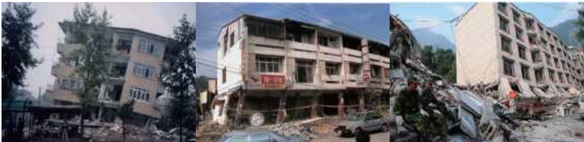
[그림 8-16] RC조 저층 건축물의 지진피해 사례
