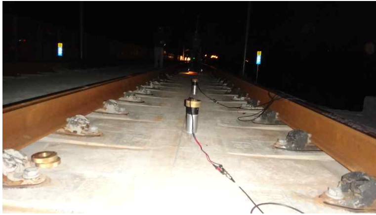
그림 2.4-19. 콘크리트궤도에서 수행한 Fractal 시험 장면
