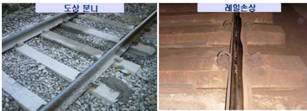
그림 1.2-6. 궤도에 발생하는 문제들(좌:도상분니, 우:레일파상마모)
