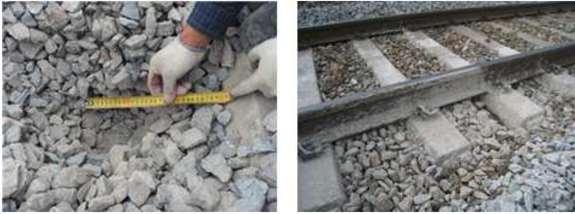
그림 2.3-10. 도상자갈 마모/파쇄(좌) 및 분니(우)
