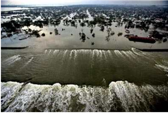
<2005년 허리케인 카트리나에 의한 제방 붕괴>
