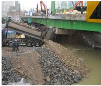
안양천 제방 유실
