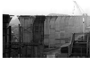
〈창사 자기부상열차 시공 현장〉
