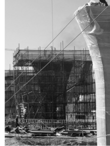
〈북경 자기부상열차 시공 현장〉
