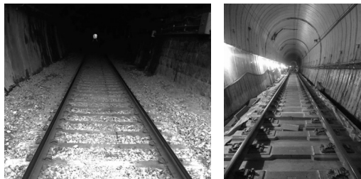
그림 68 시공 전 모습(좌), 콘크리트 급속궤도화 시공 후(우)
