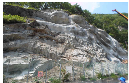
< 청산 명티지구 사면보강공사 >
