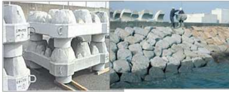
[그림 2.33] 저시멘트 콘크리트 활용 예 (항만시설)
