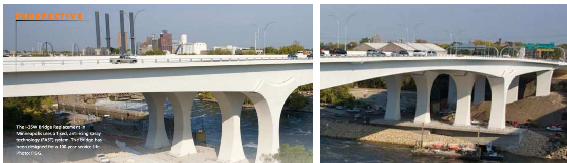
[그림 2.36] 미국 100 사용수명 설계교량 예 (I-35W Bridge, Minneapolis)
