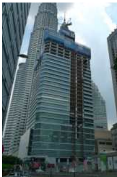
KLCC Tower(Malaysia) 시공중 변위예측기술
