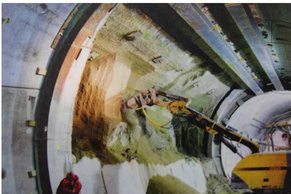
〈그림 2-6〉 기존 구조물 확장을 위한 수평굴착 사례
