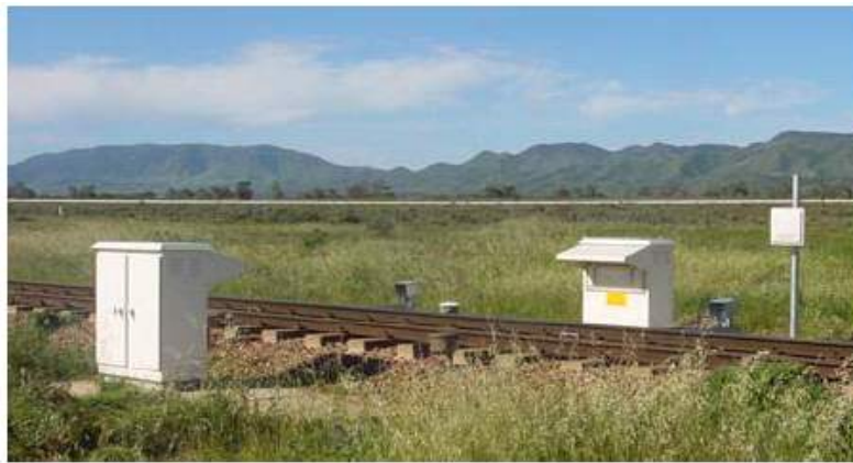
그림 54. ARTC의 RailBAM 시스템
