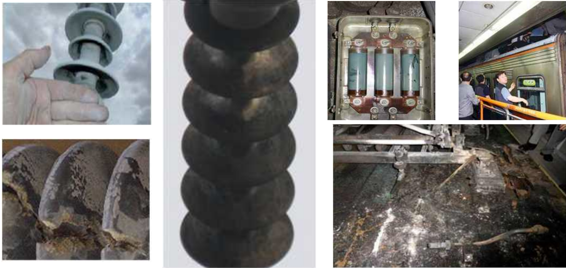
<그림6-21> 폴리머 애자의 오염 및 폴리머 애자의 성능 저하로 발생한 부산 지하철 화재 사건
