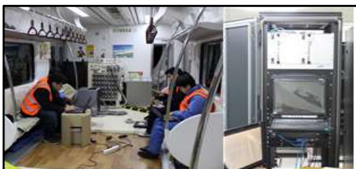
열차제어시스템 종합성능시험 차상설비/지상설비 설정점검
