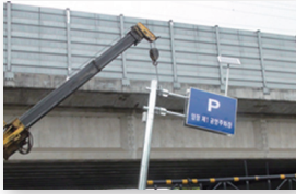
④ 설치 작업
