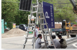
② Solar셀, 배터리, 컨트롤러 조립
