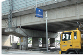
⑤ 설치 작업 완료
