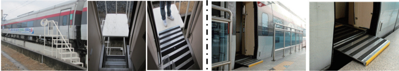
기지시운전 (오송차량기지 고상플랫폼설비)
