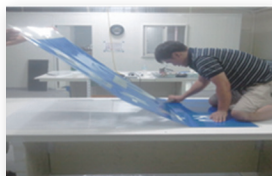
⑤ 고휘도 반사지 커팅 및 붙임 작업
