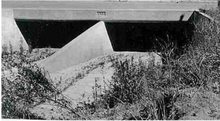
그림 6.3 Fin structure 설치 예
