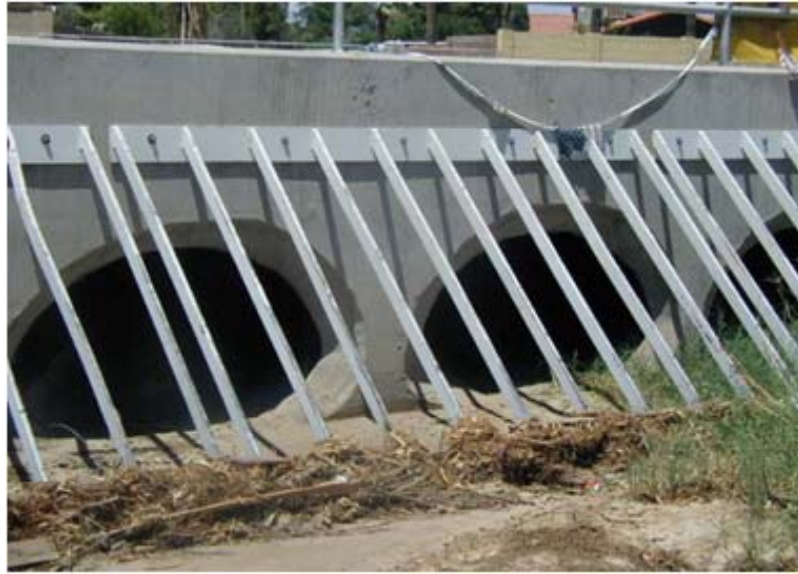
그림 6.2 Debris grill 설치 예
