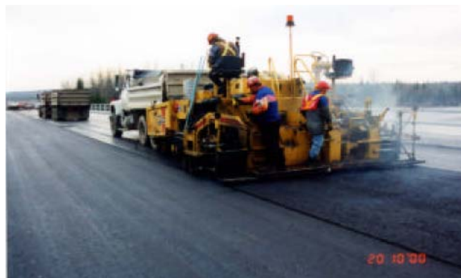
그림 4-9 교면포장 시공 사례
