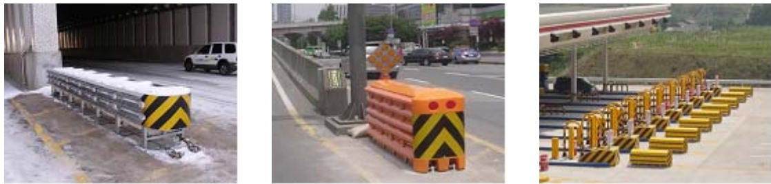
그림 2-5 국내에 설치된 충격흡수장치
