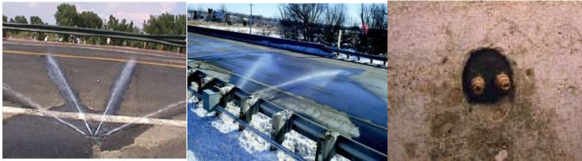
그림 5-21 용설액 분사시스템
