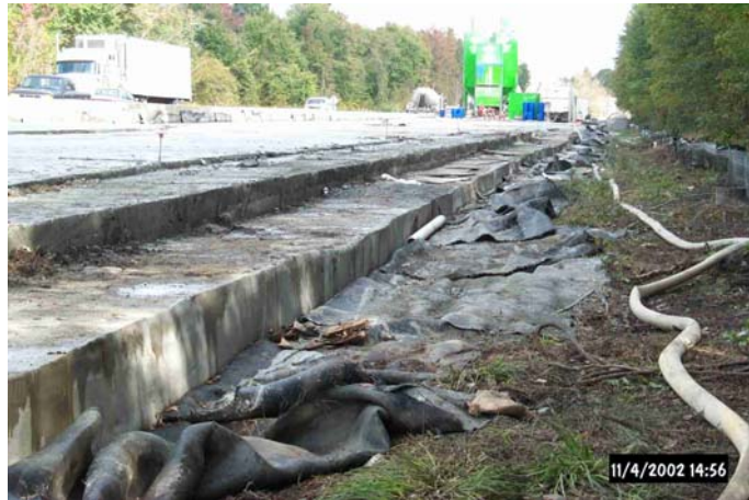
그림 5-17 연약지반상의 Hwy-64 도로건설 시공전경
