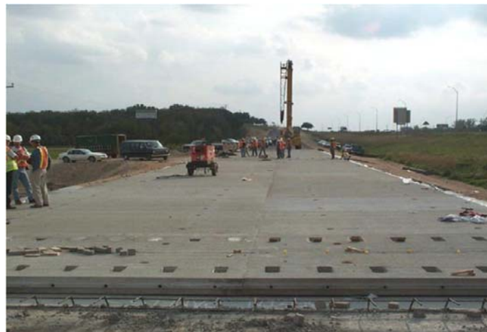
그림 4-7 프리캐스트 시공 사진
