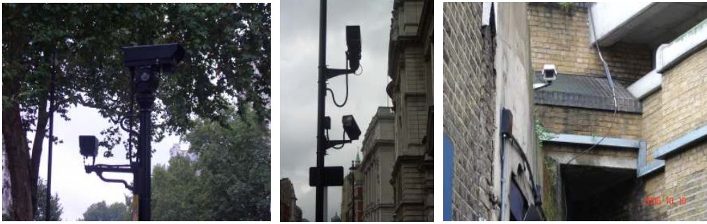
[그림 2-23] 도시 내 CCTV설치
