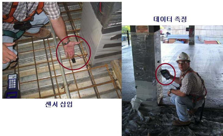
[그림 2-12] 센서이용 콘크리트 양생관리
