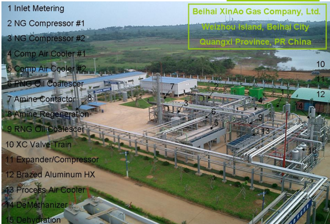
그림 5.2 중국 Weizhou섬의 LNG plant 전경
