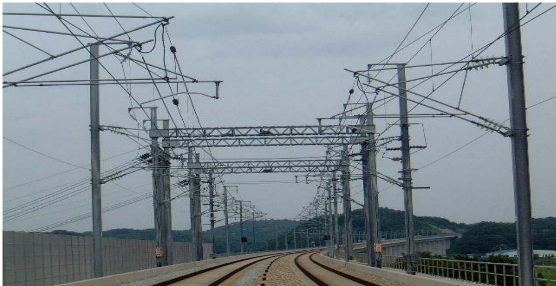
< 그림 3-2 고속선 및 경부선 KTX운행구간(이중오버랩) 전경 >
