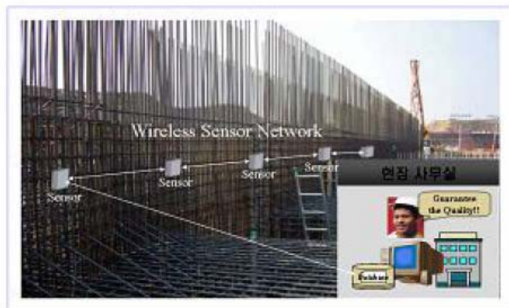
<그림 20. 콘크리트 양생 관리 시스템>
