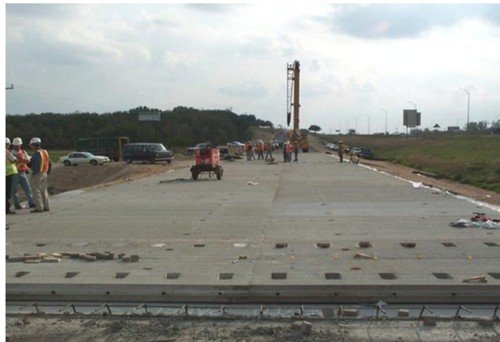
그림 4-6 프리캐스트 시공 사진
