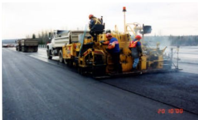
그림 4-8 교면포장 시공 사례
