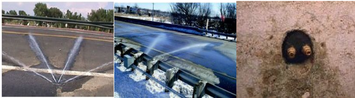
그림 5-7 용설액 분사시스템
