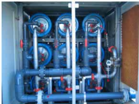
그림 2-20. SWRO 해수담수화 16인치 모듈 (Graham Tek, Singapore)(A: 16" GrahamTek Pressure Vessel, B: Rejection manifold, C: Product manifold) (출처: 사업단 상세기획 조사/분석자료)
