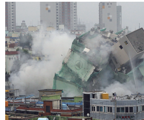
인천 가정동 상아아파트 발파해체 시험시공 모습으로 단 6초 만에 15층 건물이 해체되었다.
