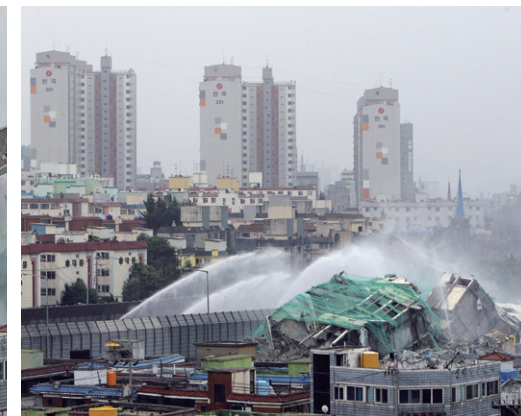
인천 가정동 상아아파트 발파해체 시험시공 모습으로 단 6초 만에 15층 건물이 해체되었다.
