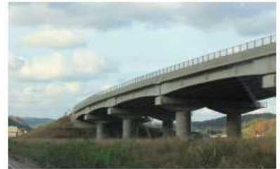
< 변단면 PSC-I 거더 전경 >
