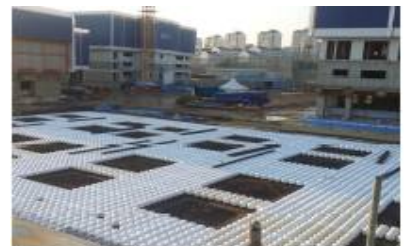
< 오금보금자리 주택지구 시공 >
