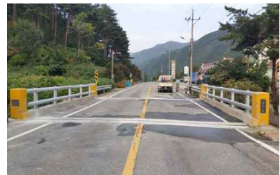
< 소교량 시공이음부 현장 적용 >
