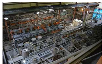
< Bottom ash 활용 건설재료 생산플라트 >
