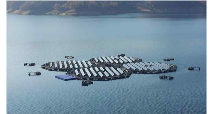
< 추적식 수상태양광 전경(합천댐) >
