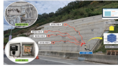
비탈면 앵커 자동측정 모니터링 시스템
