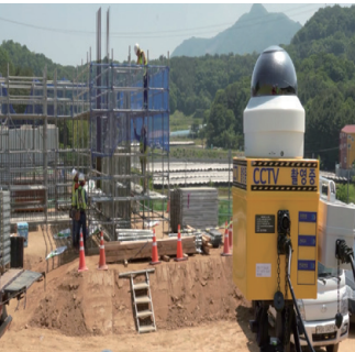
CCTV를 이용한 임시구조물 데이터 수집
