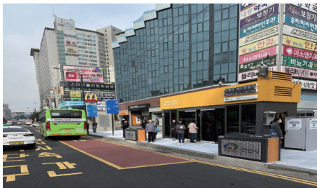
스마트 버스정류장, 그린월, 기능성 아스팔트 콘크리트 포장 등을 적용한 도로변 미세먼지 저감 실증 현장
