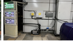
지하철 레일 온도 변위 모니터링 및 자동 살수 시스템
