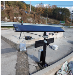
태양광 배터리를 이용한 낮은 가로등 테스트 설치
