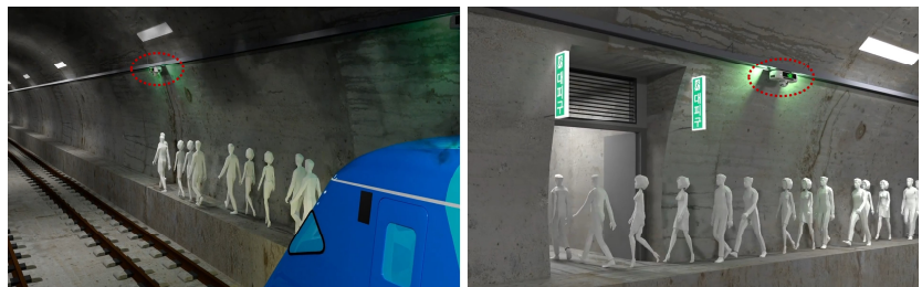
〈이동형 영상감시시스템을 활용한 철도터널 내 승객피난지원(예시)〉
