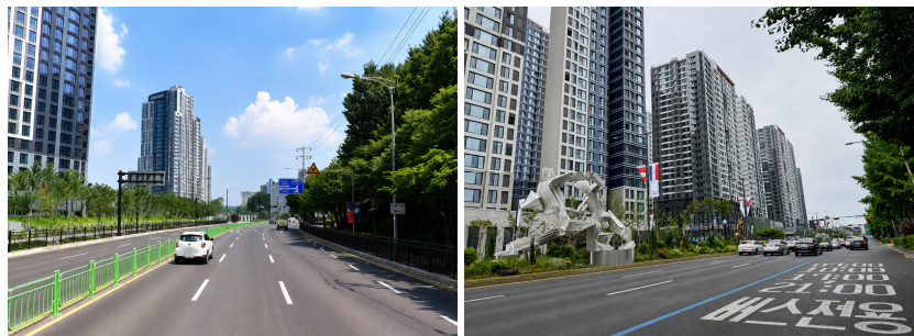
〈현장 전경(고양 풍동지구, 잠실 미성크로바)〉
