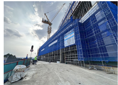
〈건설현장 비계구조물 전경〉
