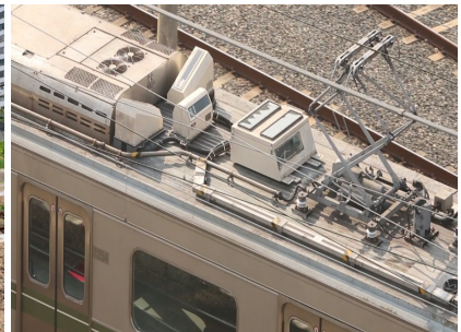
〈2호선, 4호선 검측장치 설치사례〉
