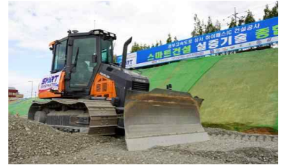
<무인화 건설장비 자동화 관제 실증시연(상서 하이패스IC)>
