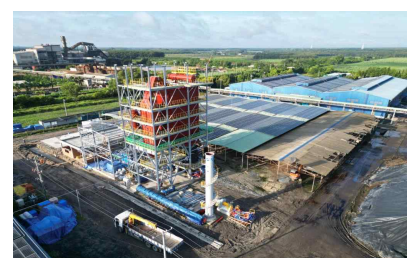
<발전 및 보일러 설비 설치>
