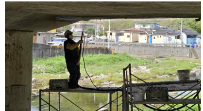
<숏크리트 대단면 보수>
