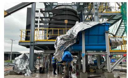
<선회식 연소설비 설치>
