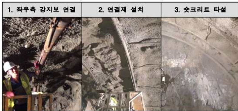
[그림] CFT 강지보재 시공기술의 시공절차 및 방법
