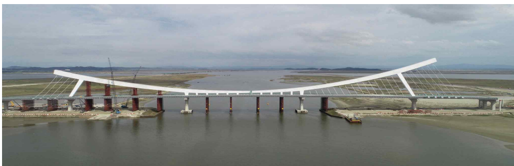
[그림] 만경대교 리버스 아치교 시공 전경
