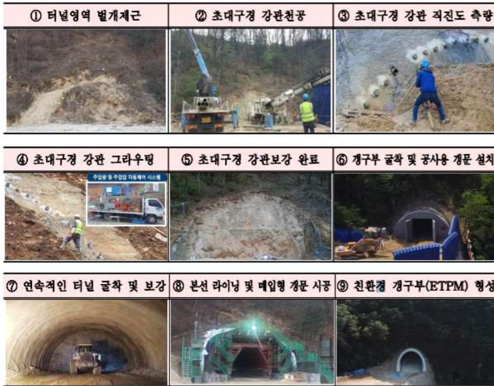
[그림] ETPM 공법의 시공절차 및 방법
