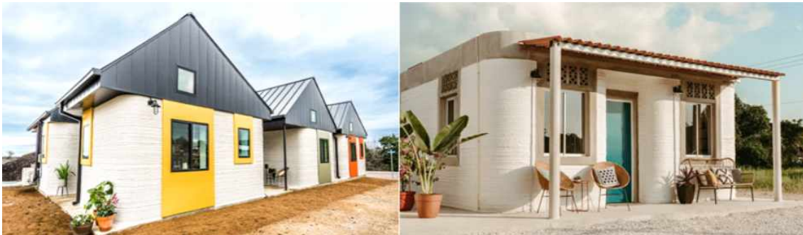
[그림] (좌) 오스틴에 건설한 첫 3D 프린팅 주택, (우) 뉴스토리와 함께 멕시코에 건설한 3D 프린팅 주택
