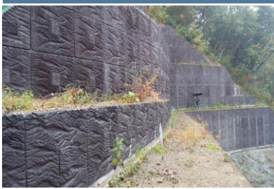
〈경량 프리캐스트 패널 이용 절토부 응벽 설치 간소화 기술〉
