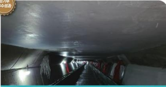
서울특별시 하수관거 적용 박테리아 활용 수처리 콘크리트 구조물 자기치유 보수 공법
