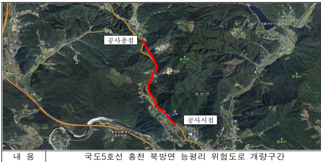
내 용 국도5호선 홍천 북방면 능평리 위험도로 개량구간
