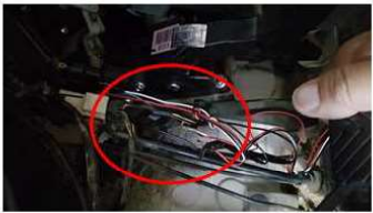
26. 차량 배선 배선 결선 작업 III
