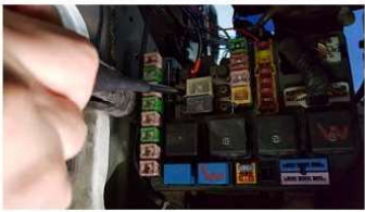
24. 차량 배선 결선 작업 I
