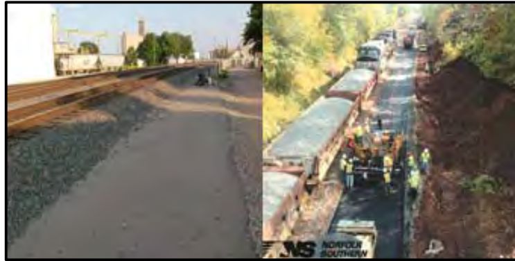
[그림 2-17] 미국 유도상 아스팔트 궤도 및 시공 장면
