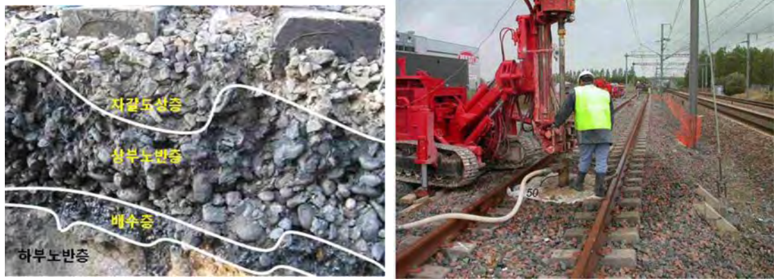
[그림 4-2] 자갈도상의 상태 점검 및 보강
