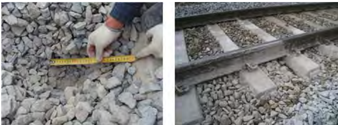
[그림 2-4] 도상자갈 마모/파쇄(좌) 및 분니(우)
