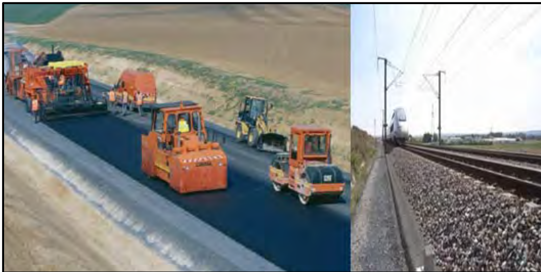
[그림 2-15] 프랑스 유도상 아스팔트 궤도
