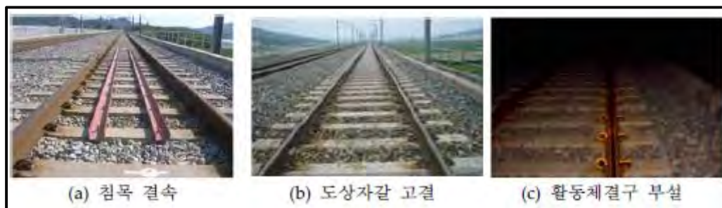
[그림 2-9] 교량신축이음매부 궤도틀림 저감 공법
