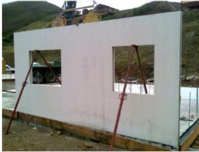
<그림 3 - 현장에서 밀잡이 보(plinth beams) 위에 GFRG 패널을 설치>
