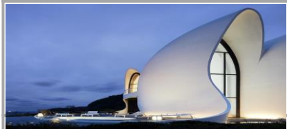
슈퍼 콘크리트 개발(수명 200년)
