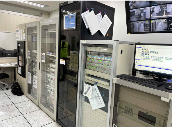
그림 2-2-1 수신기 설치 상황 및 관제 화면
