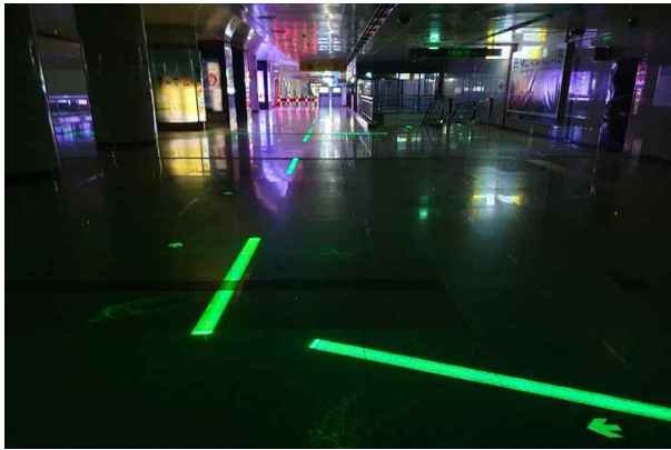
그림 2-3-9 인공지능 기반 화재대피로(좌, 기계연), 스마트폰 기반 화재대피로(우) 유도 시스템
