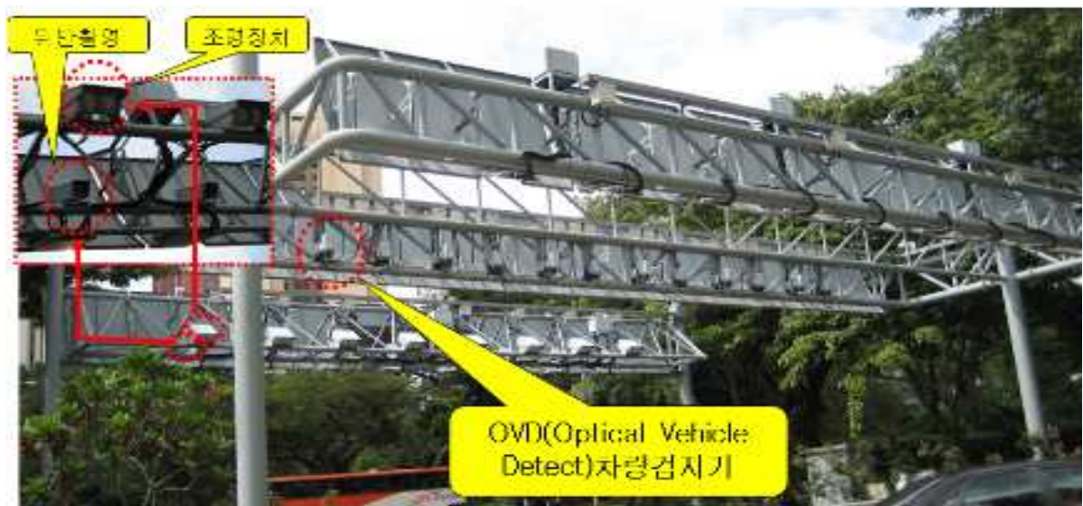
<그림 9> 광 검지기를 이용한 다차로 차종분류시스템
