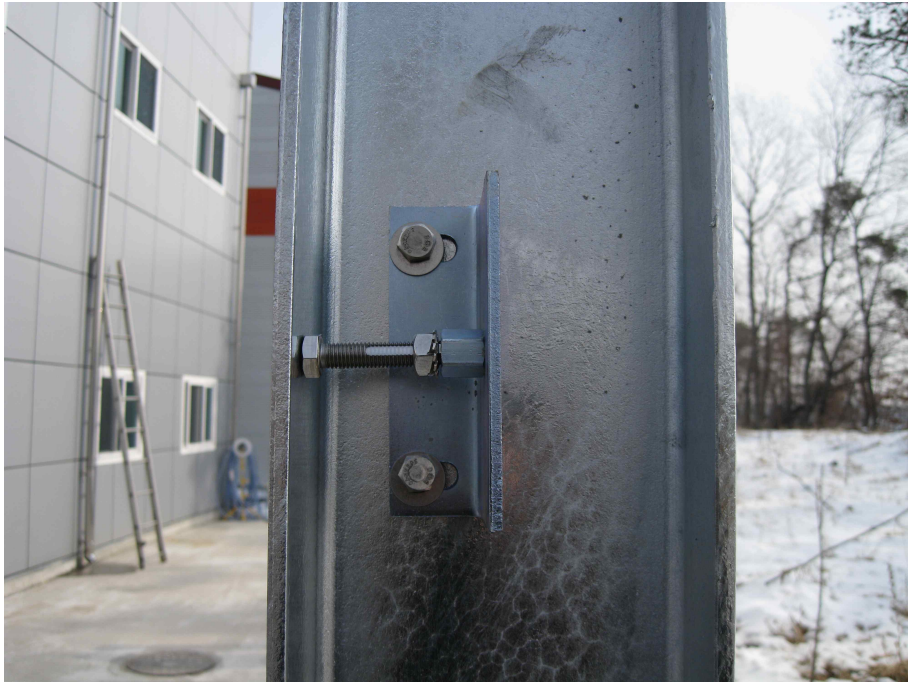
(c) 지주내 클램프 설치
